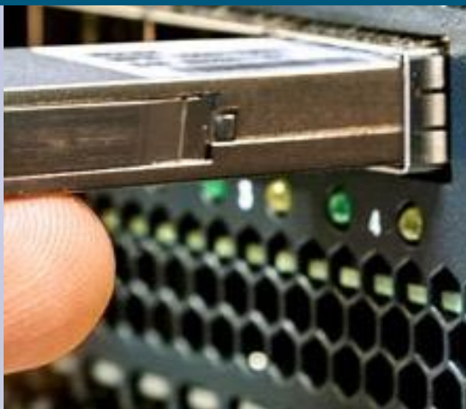
数据中心/5D Data Center/5G
