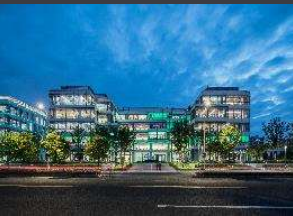
2018.1 迁入昕诺飞大中华区总部新大楼
