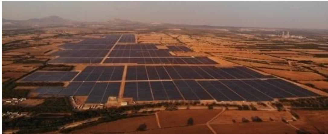
墨西哥，地面电站
