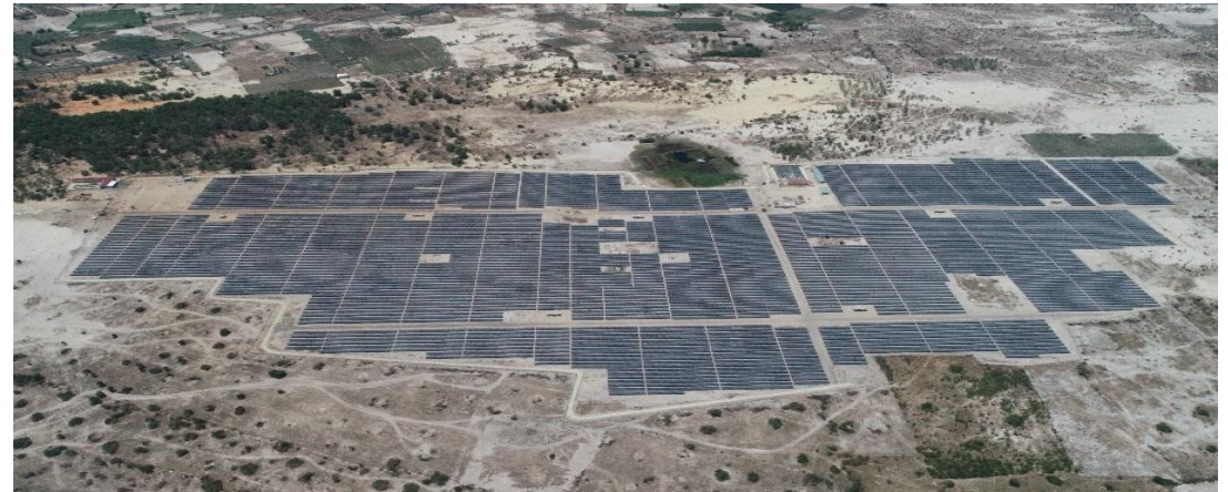
越南，地面电站
